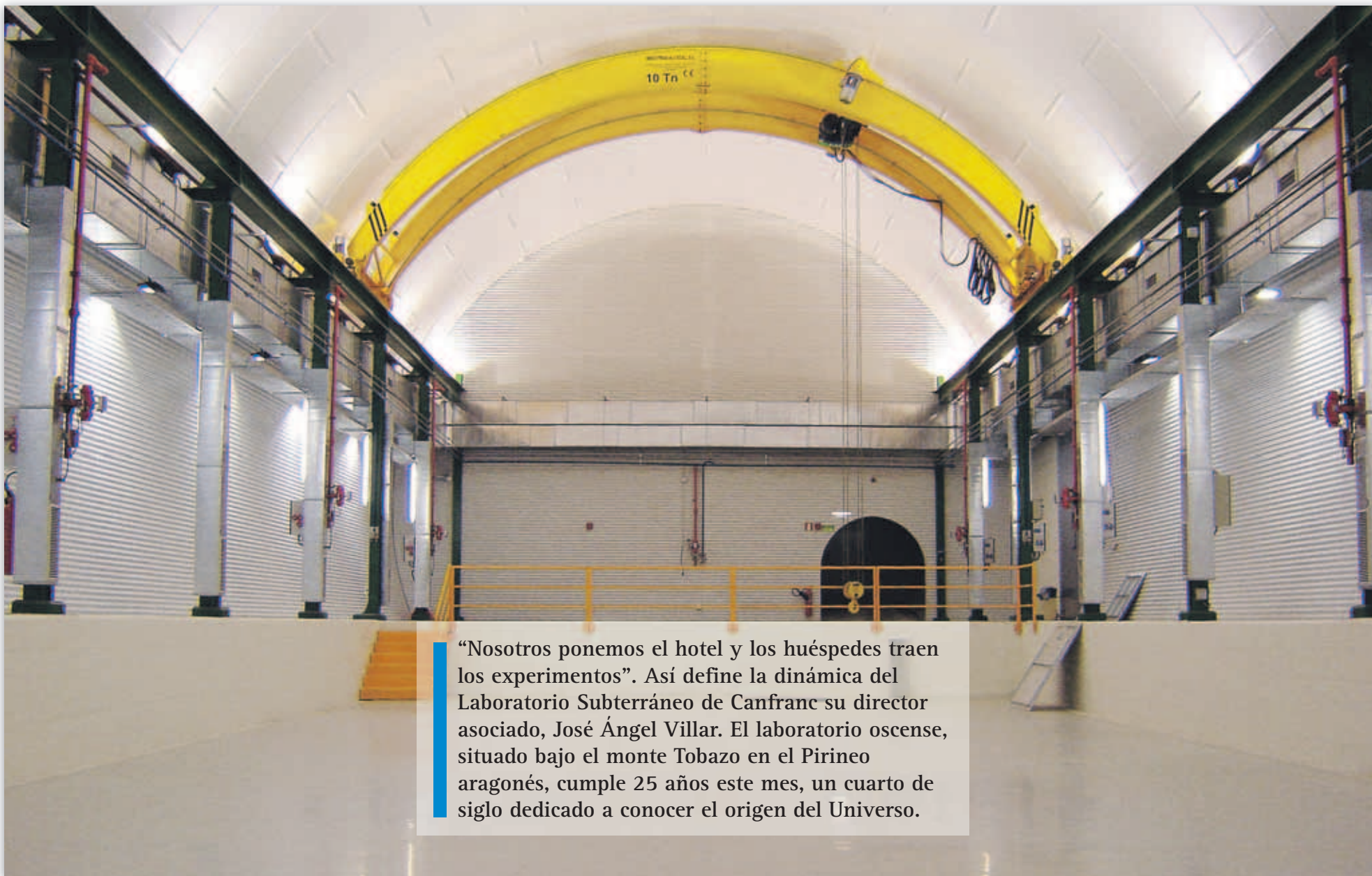
Las galerías para experimentos del Laboratorio Subterráneo de Canfranc (LSC) están excavadas en la roca a 850 metros de profundidad
